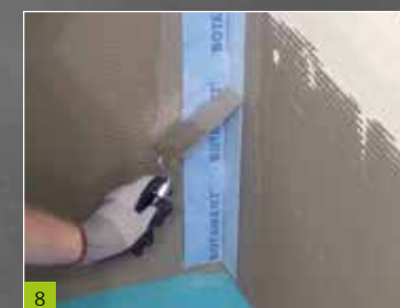
8 Einlegen des Sanitärabdichtbandes Botament® SB 78 in die frische Lage Botament® MD 1
