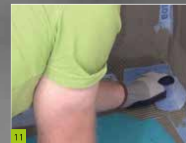
11 Einarbeiten von Botament® SB 78 im Eckbereich Botament® Duschboard zu Botament® BP Bauplatte
