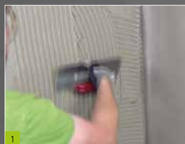
1 Auftragen des Fliesenklebers Botament® M 21 Classic
