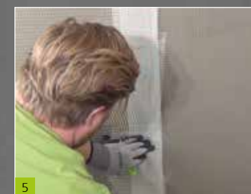
5 Fixierung des Gewebestreifens Botament® GS 12
