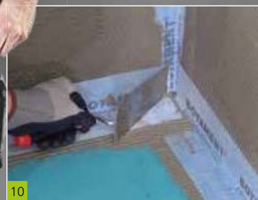
10 Einarbeiten von Botament® SB 78 im Eckbereich Botament® Duschboard zu Botament® BP Bauplatte
