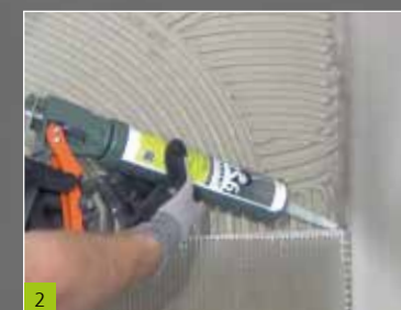
2 Stoßverklebung der BP Bauplatten mit Botament® MS 6 (Hinweis: Kreuzfugen sind zu vermeiden)
