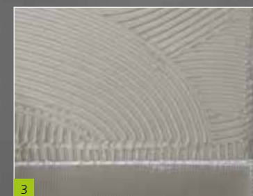
3 Zusammenfügen der BP Bauplatten
