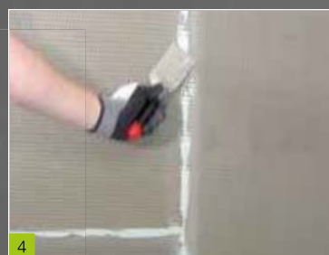
4 Glattstreichen des Überschusses mittels Glättkelle
